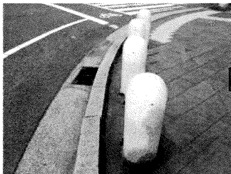
R5.3 目地に樹脂モルタル注入
