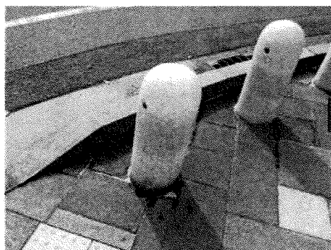
R5.3 目地に樹脂モルタル注入
