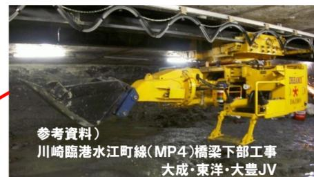
作業室において、空気圧を保ちながら（圧気しながら）地下掘削を行い、コンクリートの基礎を構築します。
