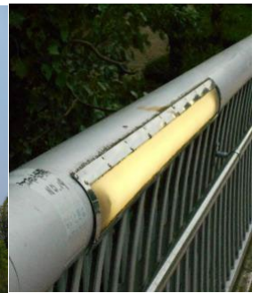
歩道橋の蛍光灯(No.19) 全て1灯式
